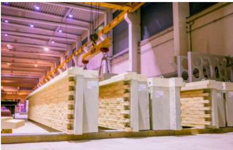
Bildunterschrift: Produktion der Fertigteil-Klinkerfassade im Max Bögl-Werk in Sengenthal (hier für den 1. BA)
