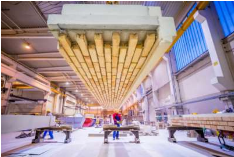
Bildunterschrift: Produktion der Fertigteil-Klinkerfassade im Max Bögl-Werk in Sengenthal (hier für den 1. BA)
