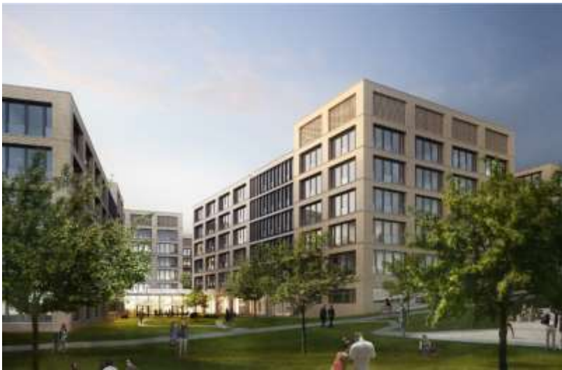
Bildunterschrift: Blick auf das Haus 7/9 mit Aussensportanlagen
