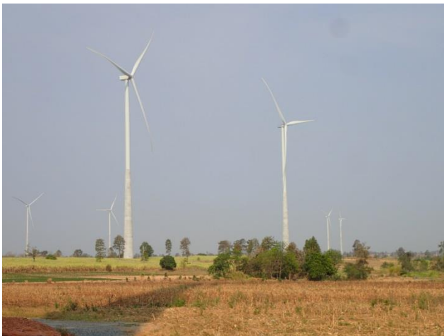
Produziert mit lokalen Rohstoffen: Hybridtürme der Windfarm Thepharak. Bildquelle: Max Bögl Wind AG
