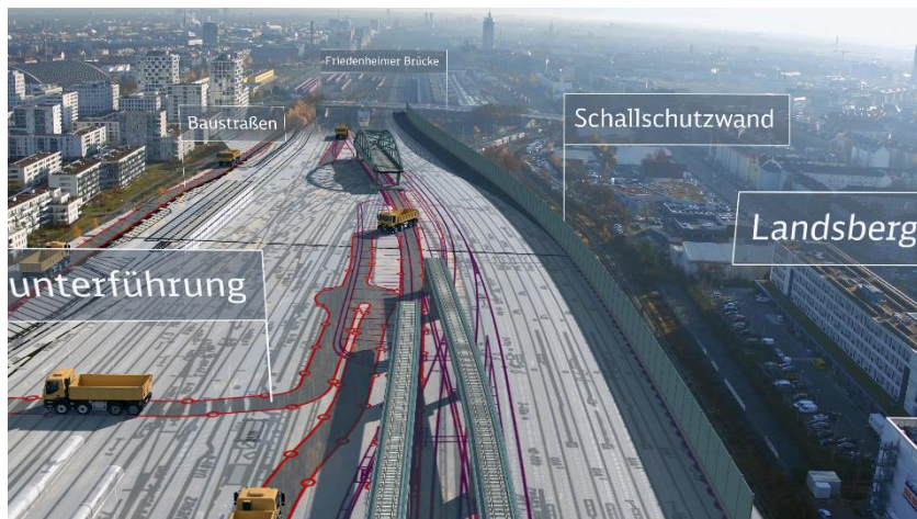
Visualisierung VE 10: Laim – Baustraßen und Schallschutzwand Quelle: Deutsche Bahn AG / Fritz Stoiber Productions GmbH
