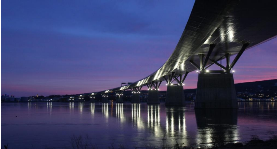
Sundsvallbrücke Schweden / Foto: Firmengruppe Max Bögl
