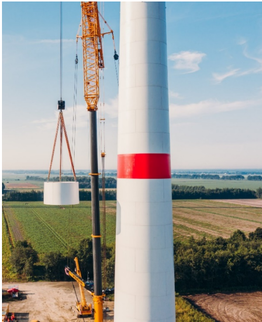
Bildunterschrift: Hybridturm Bögl bei der Montage Fotonachweis: Max Bögl Wind AG, Andreas Mayr
