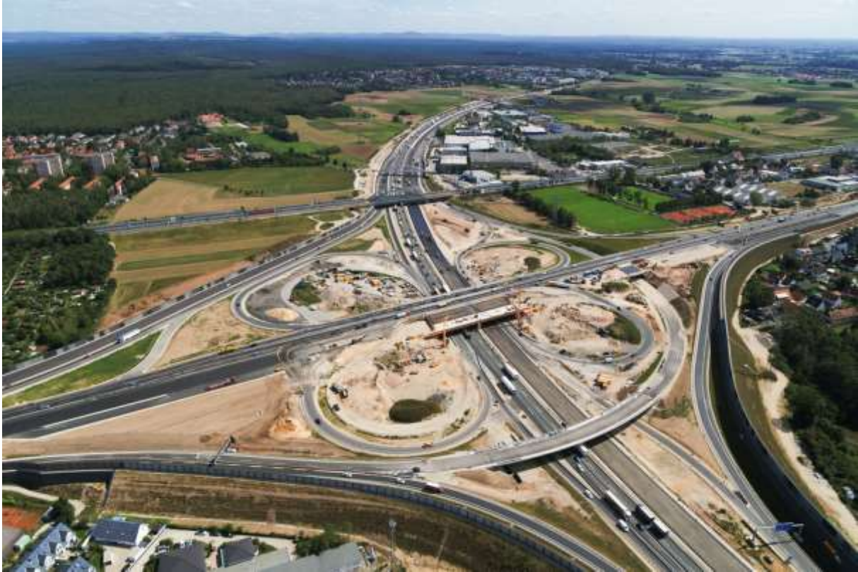
Autobahnkreuz Fürth/Erlangen während der Bauphase
