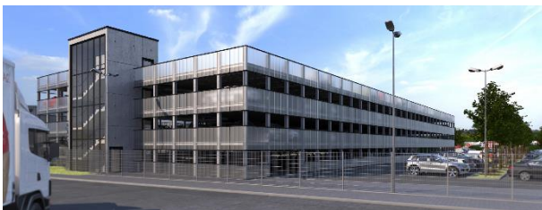
Das Parkhaus bietet Platz für 426 PKWs und wird im Parkhaussystem Bögl in Stahlverbundbauweise errichtet. Bildquelle: phase 5 GmbH
