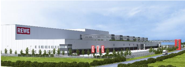
Der neue REWE Zentralstandort Nord mit einer Fläche von 24 Hektar Bildquelle: phase 5 GmbH
