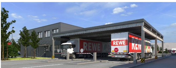
Zum Zentralstandort Nord gehört unter anderem auch noch eine LKW- und PKW-Tankstelle sowie eine entsprechende Waschhalle und ein Pfortnengebäude. Bildquelle: phase 5 GmbH
