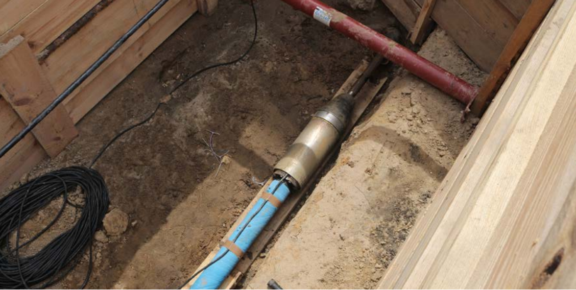
Einschieben des Zuggestänges in den Altrohrstrang
