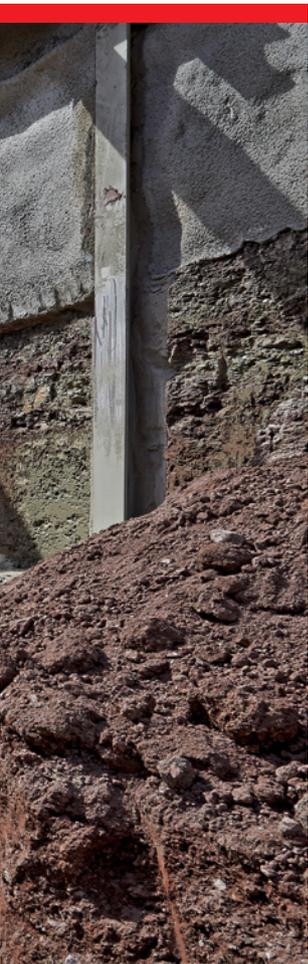
Trägerbohlwände kommen für senkrechte Baugrubenwände zum Einsatz. Die Vorteile liegen in der hohen Anpassungsfähigkeit bei Hindernissen, der Einsatzfähigkeit in den meisten Bodenarten, der Wiedergewinnbarkeit der Bauteile und der Wirtschaftlichkeit des Verbausystems. Als Ausfachung zwischen den Tragelementen kommen Holzbohlen, Spritz- oder Ortbeton, Spundwände oder Fertigteile zum Einsatz. Die Tragglieder, im Wesentlichen Stahlträger, können gerammt, gerüttelt oder gebohrt werden.
