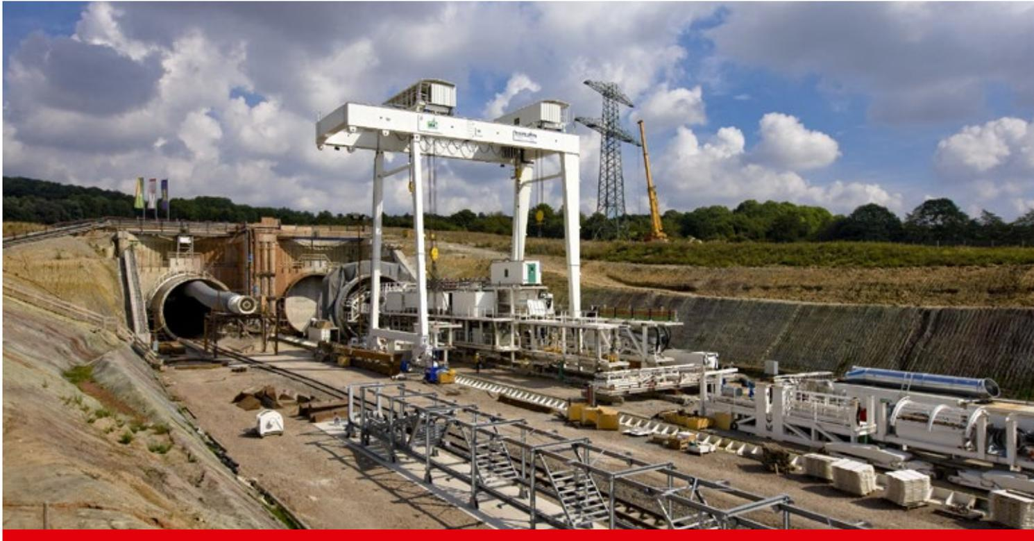
Der 8.280 Meter lange Finnetunnel in Thüringen wurde vom Bereich Tunnelbau als Co-TGF mit zwei umbaubaren Mixschilden Hydroschild im geschlossenen und offenen Modus für die DB Netz AG realisiert.
