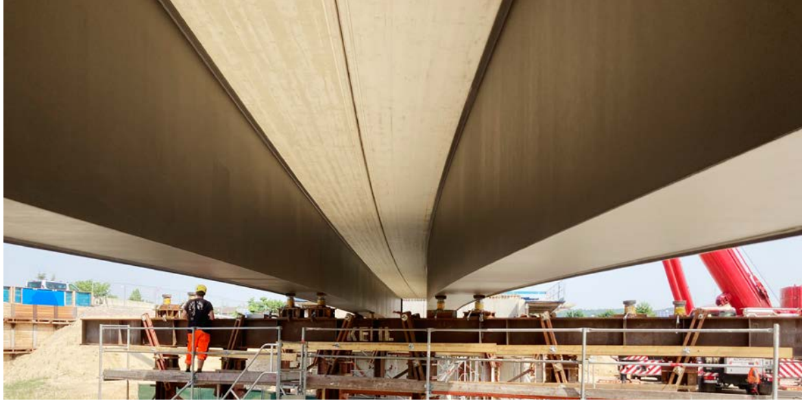
Montage des Verbundträgers Bögl auf der Baustelle
